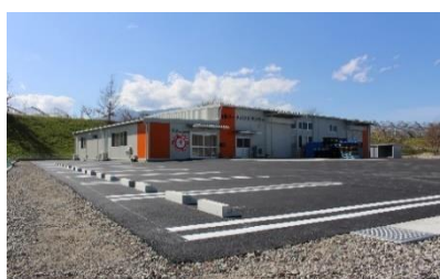
アスファルト舗装
